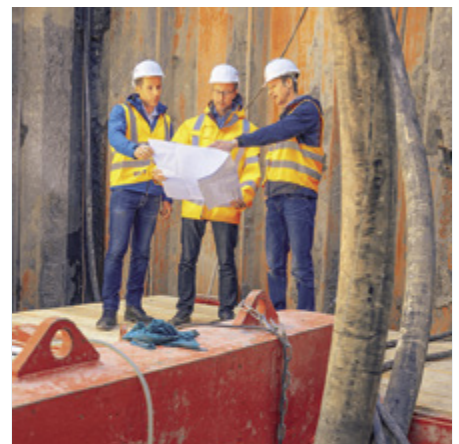
Bereichsleiter Markus Ulmer (m.) und Fernwärme-Baubeauftraggeber Sascha Englert (l.) von der Netzgesellschaft der Stadtwerke Karlsruhe studieren mit Sascha Hartig (r.) von der ausführenden Baufirma Sonntag den Plan für die Unterpressung der Südtangente im Microtunneling-Verfahren
