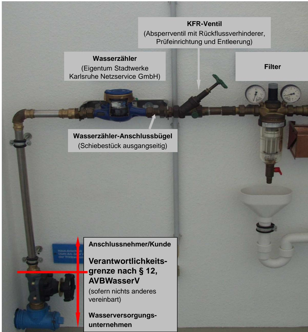
Wenn die Wasserzähler-Anlage in einem anderen Raum wie das Haupt-Absperrventil (HAE) ist oder die beim Wasserzählerwechsel austretende Wassermenge größer als 10 l ist, muss direkt vor dem Wasserzähler ein zusätzliches Absperrventil eingebaut werden.
